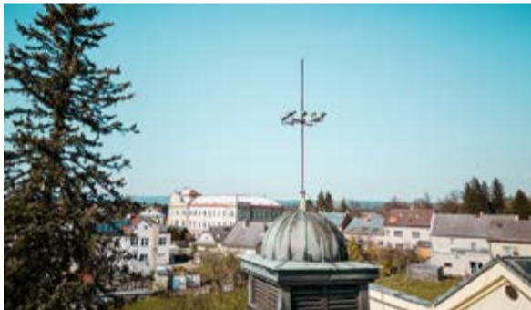
Zur Erinnerung an den Pionier wurde am Dach des Theaters der tschechischen Stadt Zamberk ein Nachbau der Konstruktion errichtet, die man bis heute besichtigen kann.
